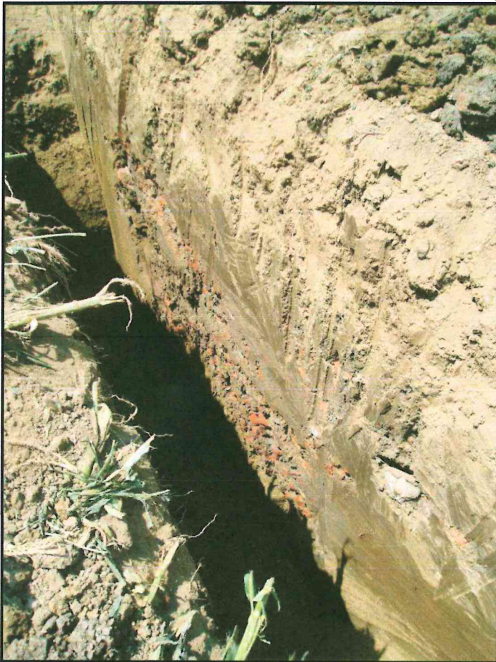
Fig. 4 – Realizzazione della Trincea I presso l'area delle villette.
